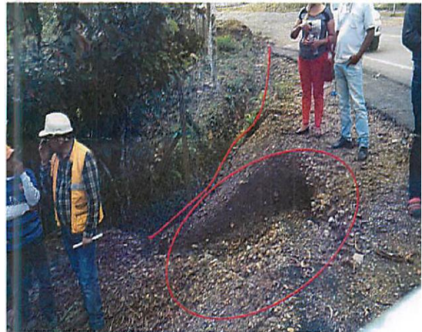
Ilustración 10. Problemas de Manejo de Aguas
