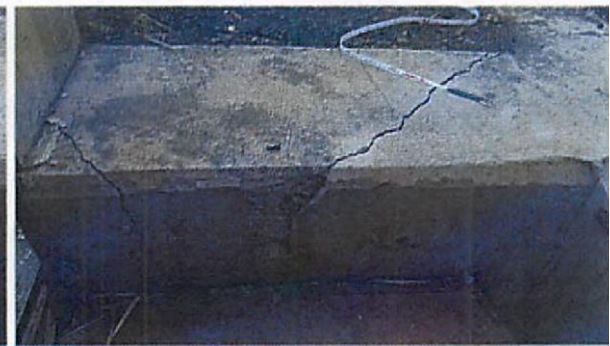
Ilustración 4. Fisuras
