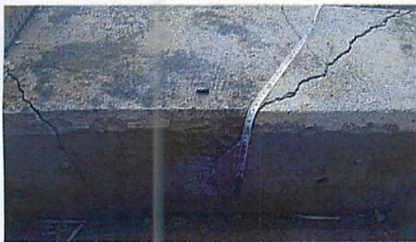
Ilustración 4. Fisuras
