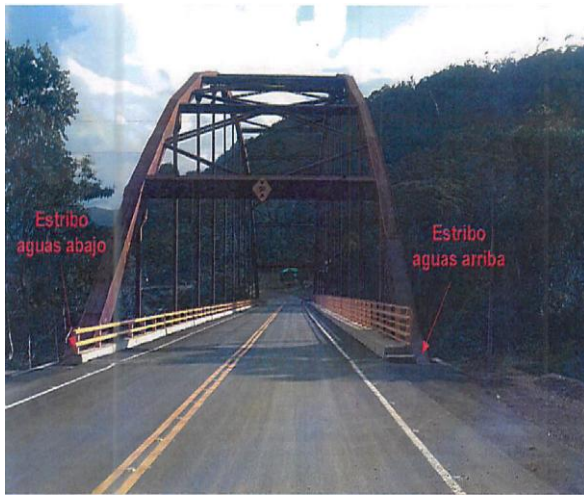
Ilustración 7. Fianco Izquierdo Pte. Quebrada Blanca
